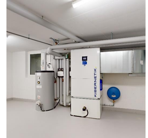
Luft-Wasser-Wärmepumpe
